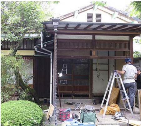
谷口さん古民家改修 工事
